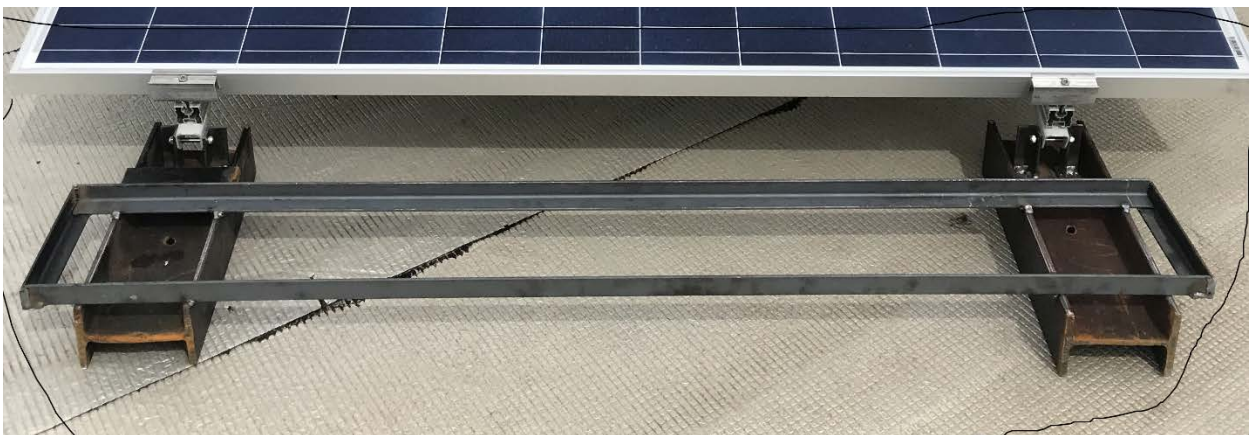
Figure 4.5 Actual Ballast Design
